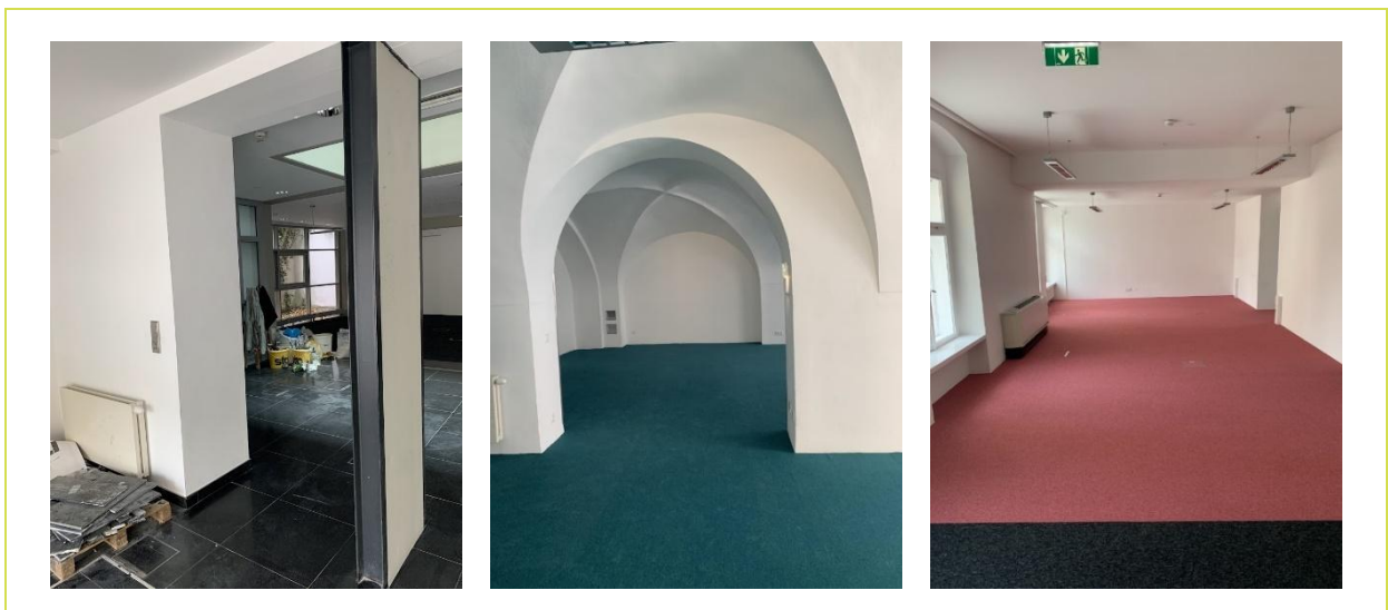
Abbildung 1: Fotos von der Baustelle und den „nackten“ Räumlichkeiten am 24. Mai 2024, Rosemarie Merl
